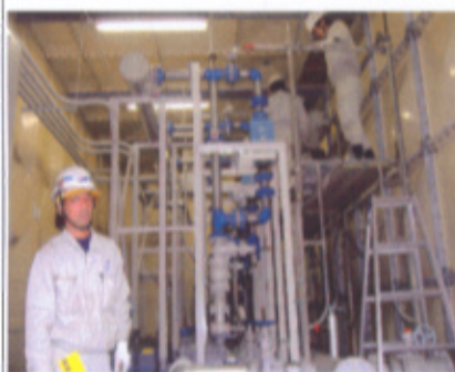
ポンプ室に3基の磁気装置を設置
